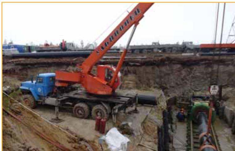
Строительство перехода через автодорогу пресси-шнековым методом
