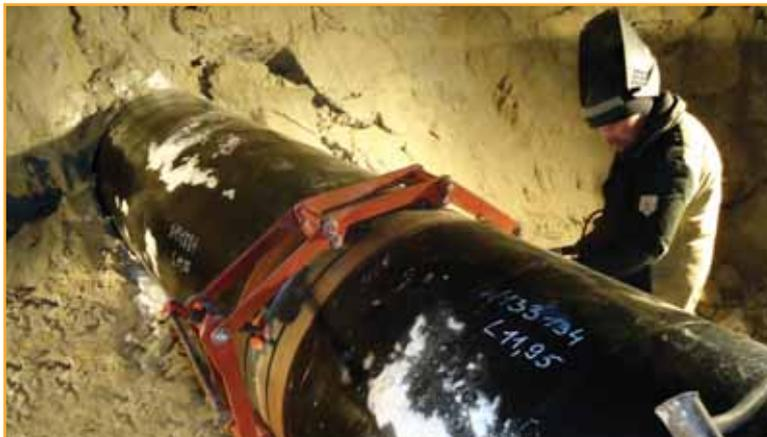
Продавливание защитного кожуха продуктопровода
