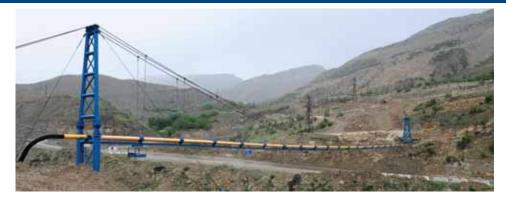
1200 человек. Проектная производительность Хунзаха порядка 400 млн м³ в год. Протяженность его составляет 48,2 км. В состав объекта вошли также три автоматические ГРС и четыре радиорелейные станции с антенными опорами. Строительство газопровода-отвода позволило газифицировать около 10,5 тыс. домохозяйств, 322 коммунальных и производственных объекта в шести населенных пунктах Республики Дагестан.
