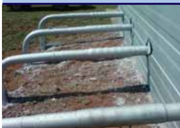
Фото 1 Блок-гребенка КНС с установленными МЭСТ (рабочее давление до 21 МПа) НГДУ «Бавлынефть»
