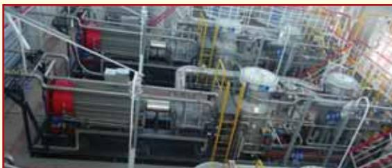
В 2011 году на ГТЭС-36 введена в эксплуатацию компрессорная станция ангарного типа, состоящая из пяти дожимных компрессорных установок (ДКУ) ENERPROJECT. Проект примечателен тем, что установки применяются для одновременной утилизации попутного газа двумя способами:
