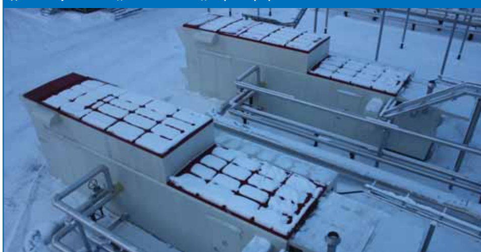
Фото 2. Цех контрольной проверки нефти НГДУ Федоровскнефть («Сургутнефтегаз»). Дожимные установки готовят ПНГ для транспортировки
