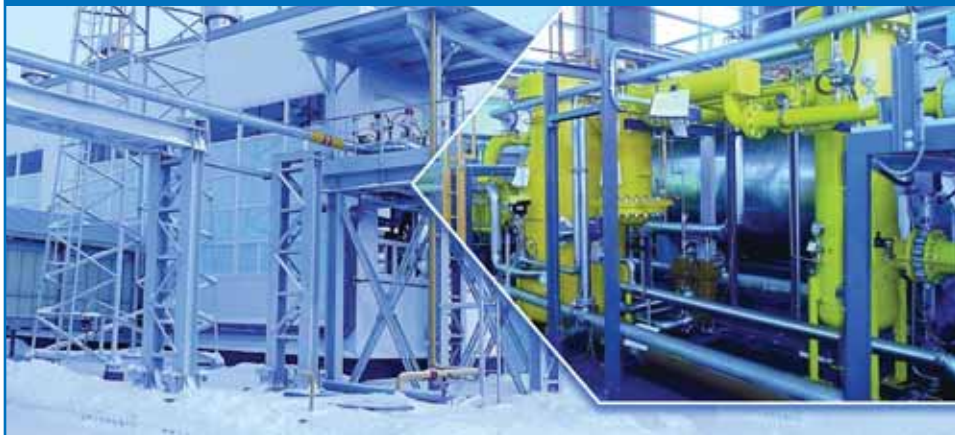
Фото 1. Газодожимная КС ангарного типа для обеспечения топливом ГТЭС-12 Игольско-Талового месторождения
