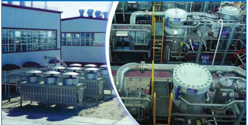
Фото 3. Компрессорная станция «ЭНЕРГАЗ-Enerproject» на ДНС-3 Северо-Лабатьюганского месторождения
