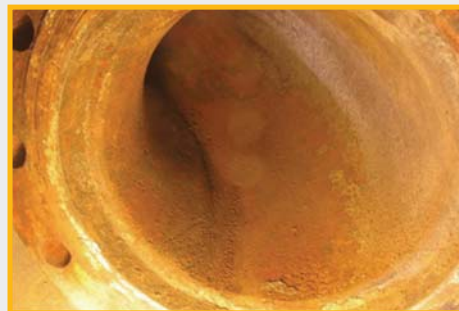
Внешний вид внутренней поверхности отвода 13ХФА
