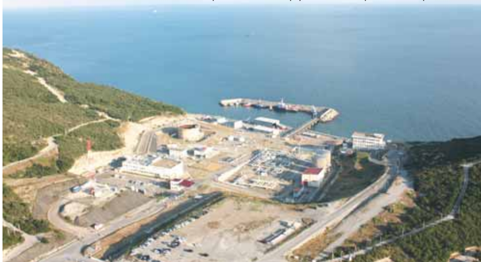
Береговые сооружения Морского терминала
