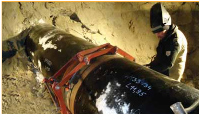
Продавливание защитного кожуха продуктопровода
