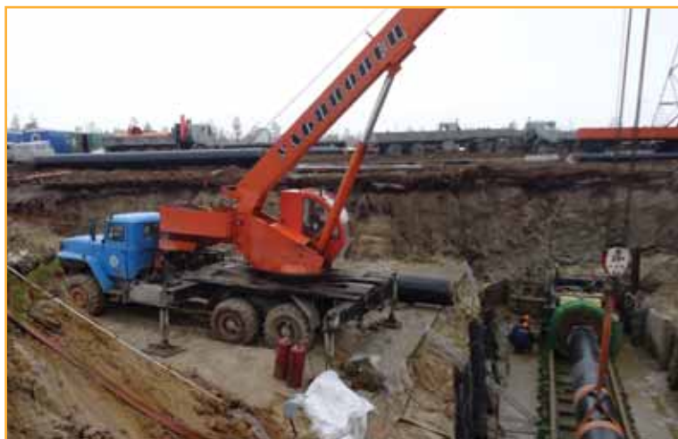
Строительство перехода через автодорогу пресси-шнековым методом
