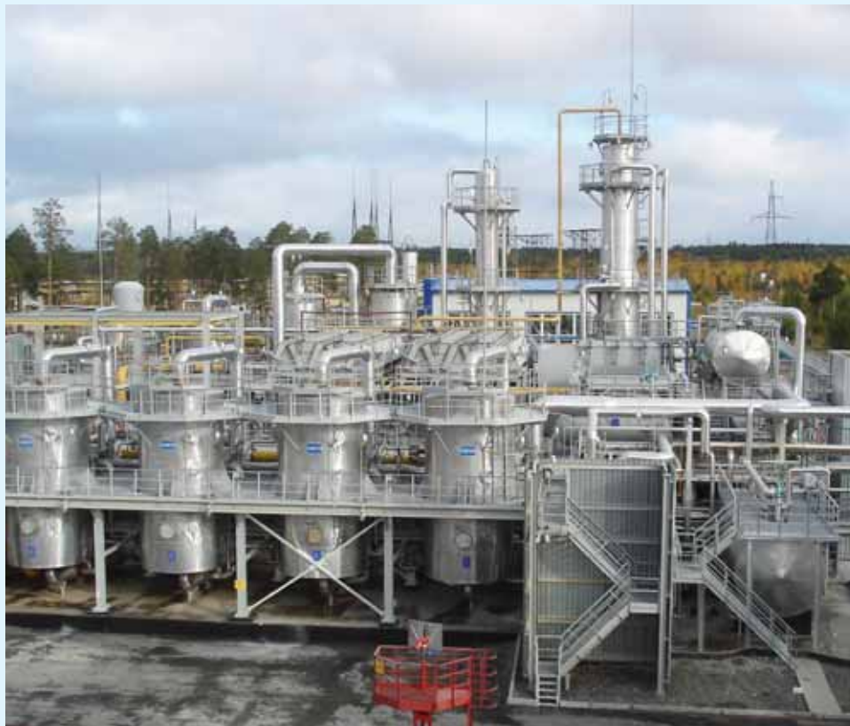
Установка по переработке попутного нефтяного газа в ОАО «Сургутнефтегаз»
