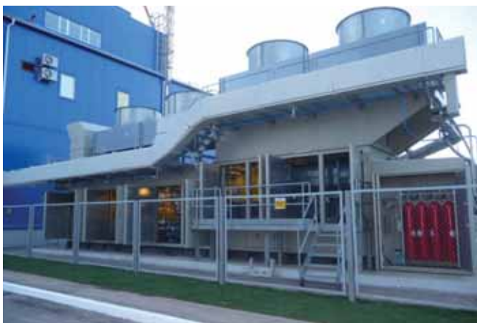
Современная двухступенчатая компрессорная установка обеспечивает топливом ПГУ-30 Калужской ТЭЦ «Квадра»
