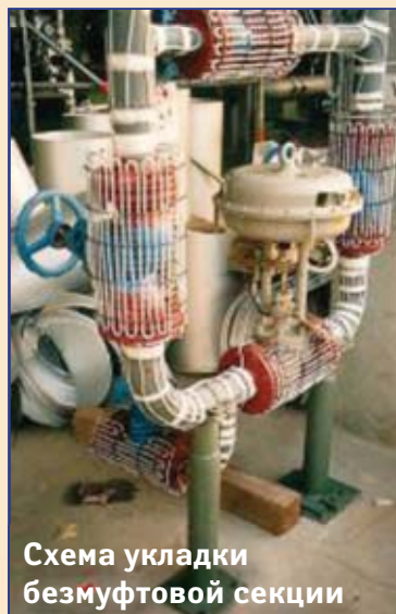
Схема укладки кабеля СНФ
