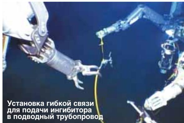
**Установка гибкой связи для подачи ингибитора в подводный трубопровод**
