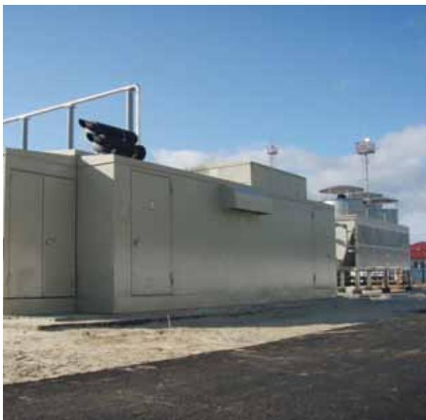
**Октябрь 2009 г.** Реализован первый проект по поставке ДКУ Enerproject с дизельным приводом. На Рогожниковском месторождении ОАО «Сургутнефтегаз» установка работает на попутном газе и используется для восстановления работоспособности местной газотурбинной электростанции в условиях отсутствия электроэнергии, что повышает надежность ГТЭС и сокращает издержки при простое генерирующего оборудования. В России это была первая ДКУ подобного назначения.
