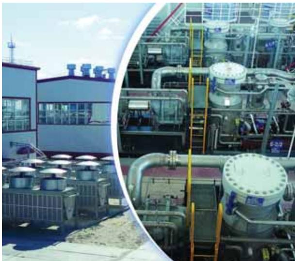
**Апрель 2011 г.** Введена в эксплуатацию дожимная компрессорная станция на ДНС-3 Северо-Лабатьюганского месторождения. Здесь решена технологическая задача, когда установки в составе одной ДКС параллельно выполняют две функции: (1) подготавливают и закачивают попутный нефтяной газ в транспортный газопровод и (2) подают ПНГ в газотурбинную электростанцию, вырабатывающую электроэнергию для объектов месторождения.
