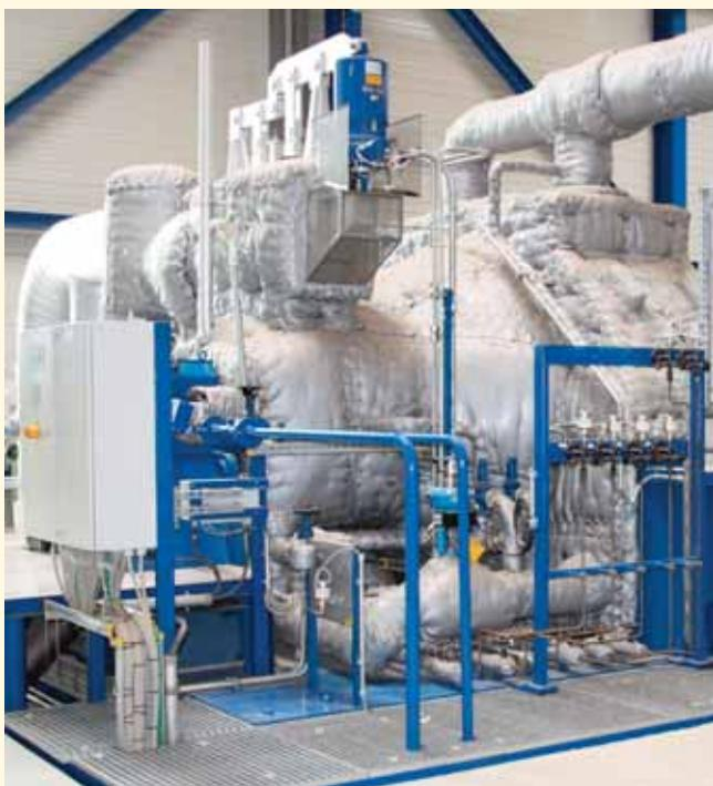
ским проектом тепловой изоляции и поддержания нормальной температуры воздуха для работы автоматики, эксплуатационную задачу точечной доступности обслуживаемых элементов, экономическую задачу по уменьшению затрат на вентиляцию рабочей зоны на 61%.
