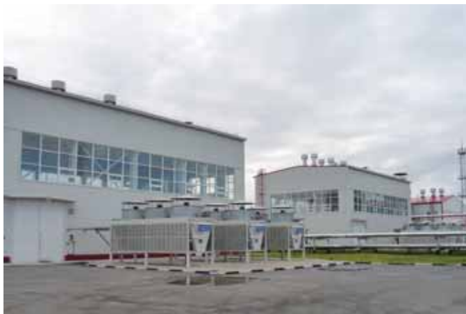
Республика Саха (Якутия). Талаканское месторождение оснащено современной компрессорной станцией
