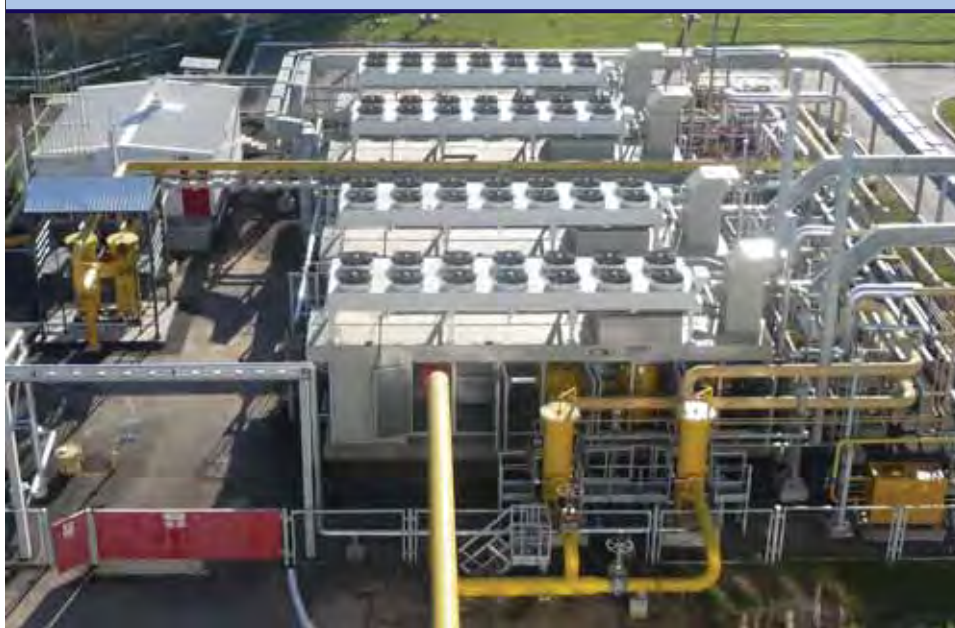
Фото 1. Система подготовки газа (ДКС, РДКС и БПТГ) для турбин ПГУ-110 Астраханской ГРЭС
