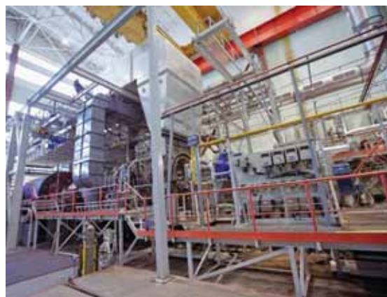
Фото 6. Испытательный цех Невского завода
