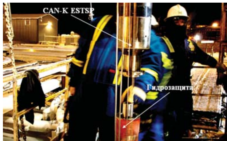
Монтаж погружного двухвинтового насоса с ПЭД
