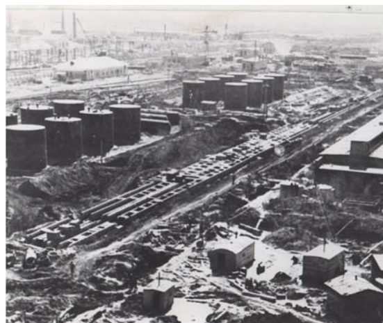
Строительство Омского НПЗ
