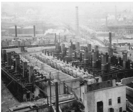
Установка дистиляции нефти, Баку, 1901 г.
