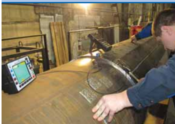
РИС.4 УЛЬТРАЗВУКОВОЙ КОНТРОЛЬ КАТУШЕК ОПОР НЕПОДВИЖНЫХ
