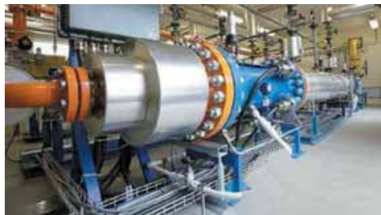
Фото 5. Газорасширительная турбина — основа инновационной электростанции
