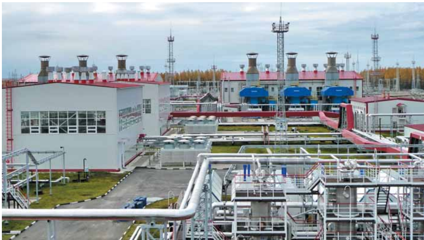
Фото 6. Газотурбинная электростанция Талаканского месторождения «Сургутнефтегаза» работает на попутном нефтяном газе
