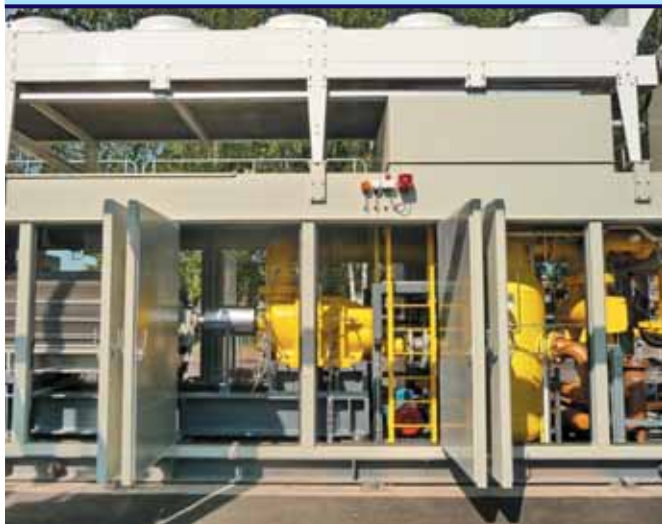
Фото 8. Модернизированная газовая компрессорная установка для ПГУ-60 Уфимской ТЭЦ-2
