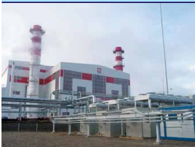
Фото 2. Компрессорная станция топливного газа для ПГУ-135 Буденновской ТЭС
