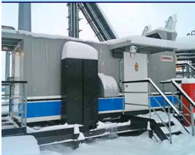
Фото 3. Вакуумная компрессорная станция на УПСВ-9 Советского месторождения
